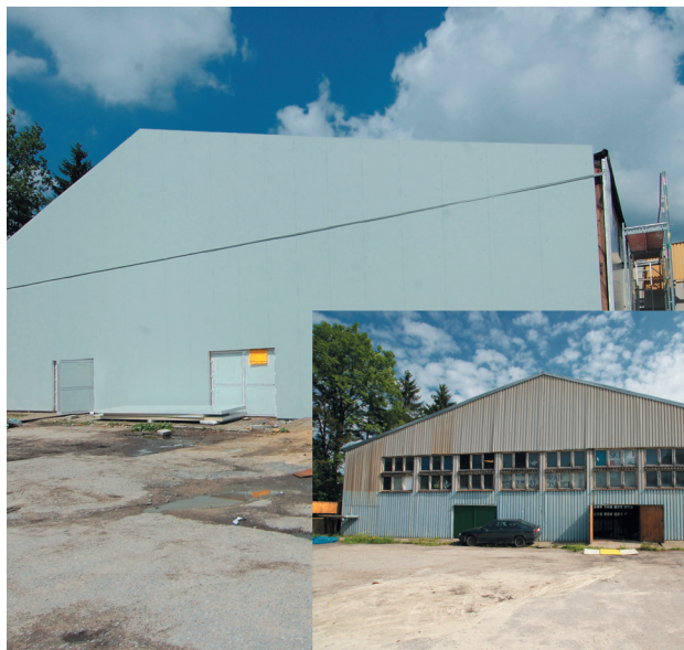
■ Termomodernizacja Hali Sportowej przy ul. Stoińskiego
