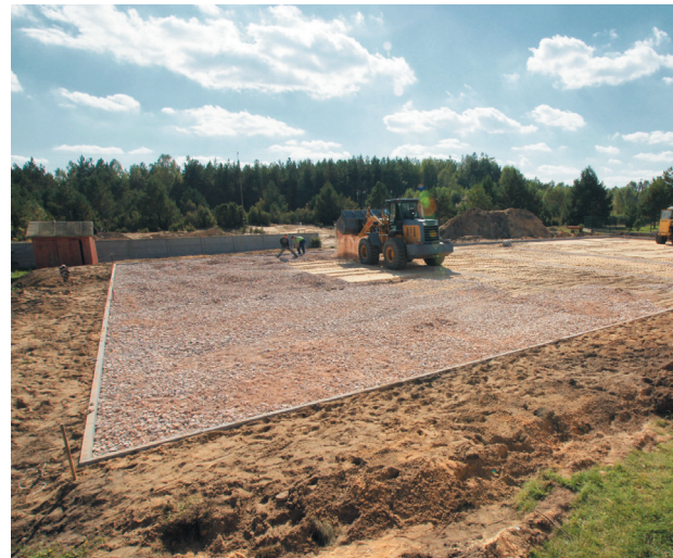
■ Budowa boiska wielofunkcyjnego w Wąsoszu. Pięć takich boisk powstaje w koneckich sołectwach
