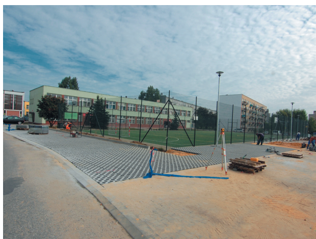
Parkingi na osiedlu Warszawska przy boisku wielofunkcyjnym
